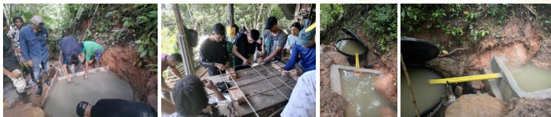
Registro fotográfico/ construcción bocatoma
